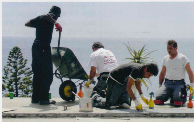
Baustelle mit Meerblick - das sind Arbeitsbedingungen!
